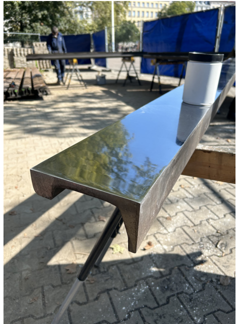
Ponçage et application de vernis sur le rail - - photo Samuel Chiner ©
