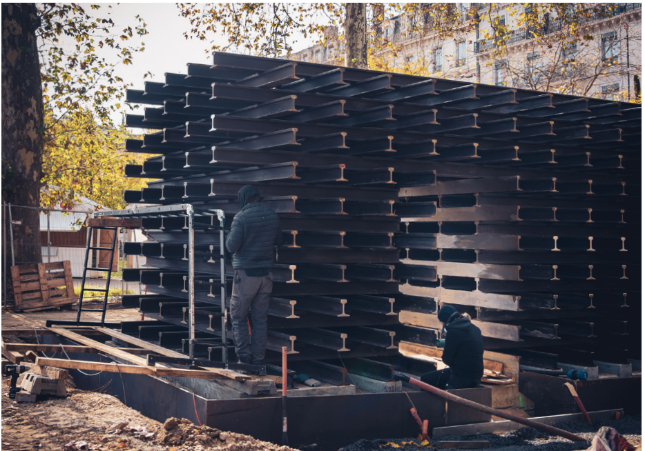
Mise en oeuvre du seuil autour de l'oeuvre. - photo Samuel Chiner ©
